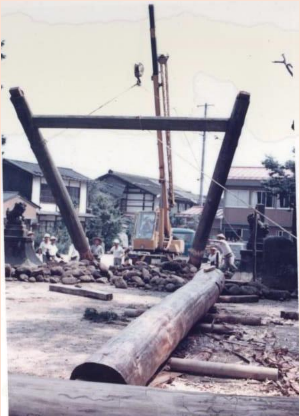
旧い鳥居の撤去作業
