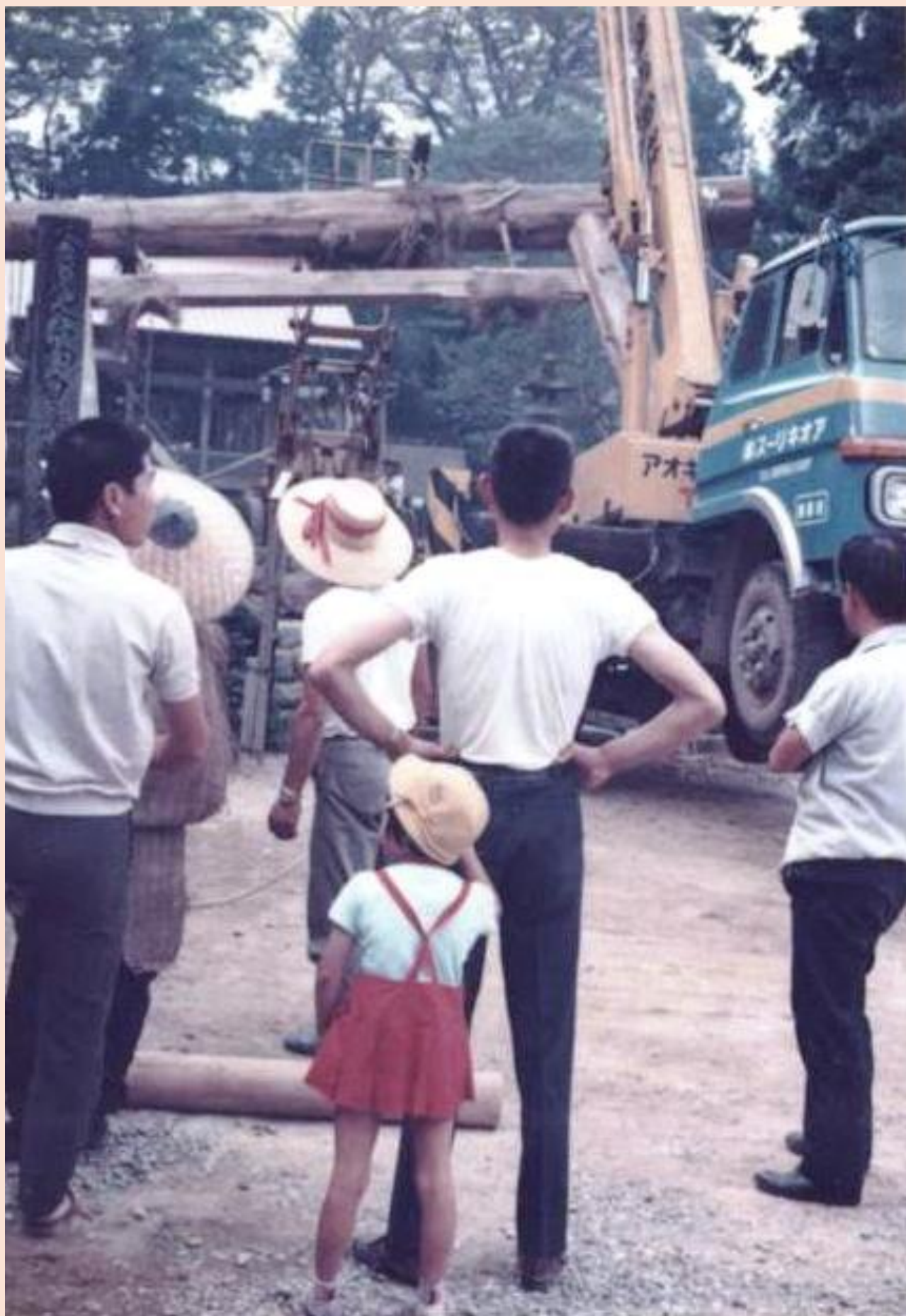
新しい鳥居の建て込み作業
