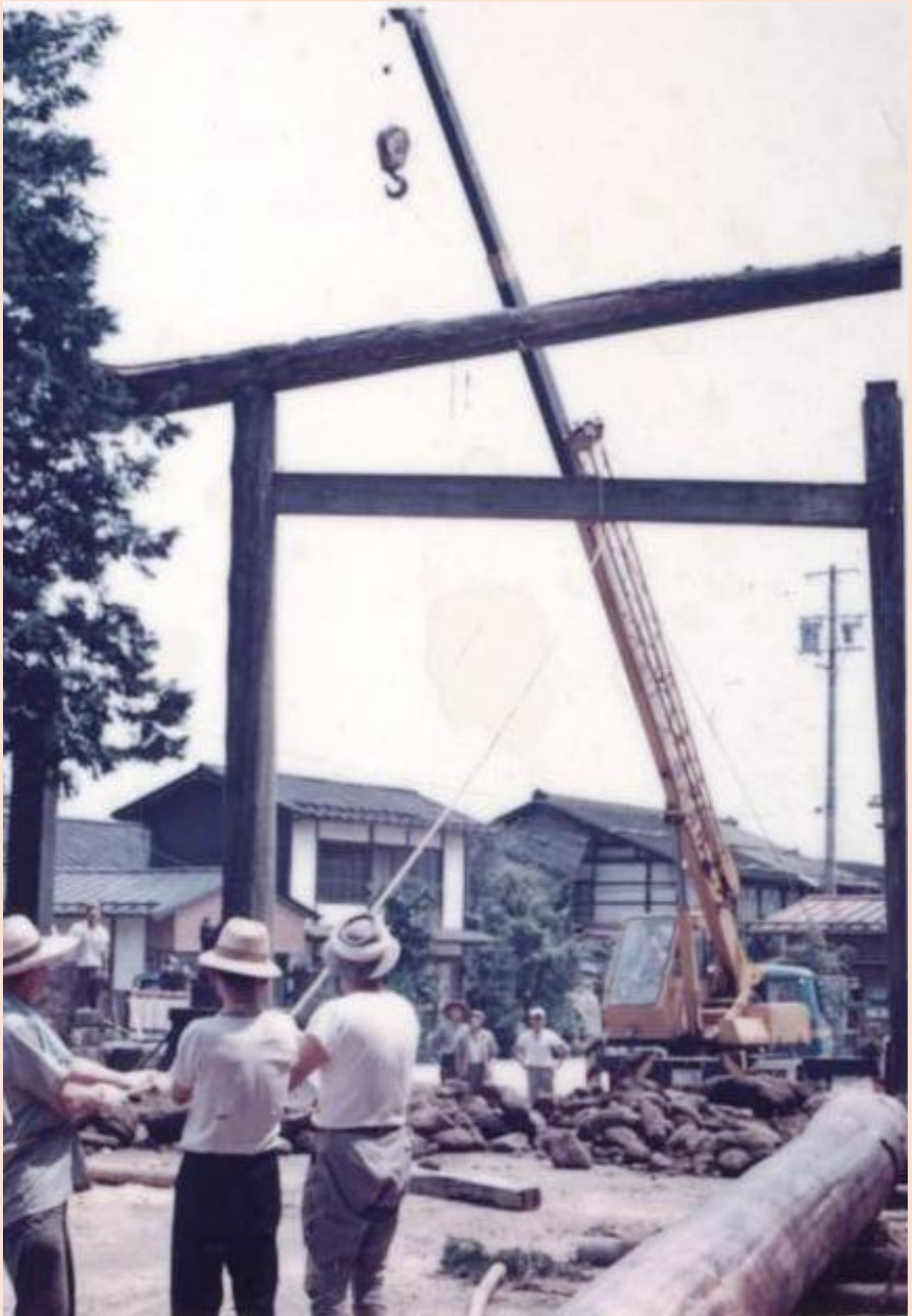
旧い鳥居の解体作業
